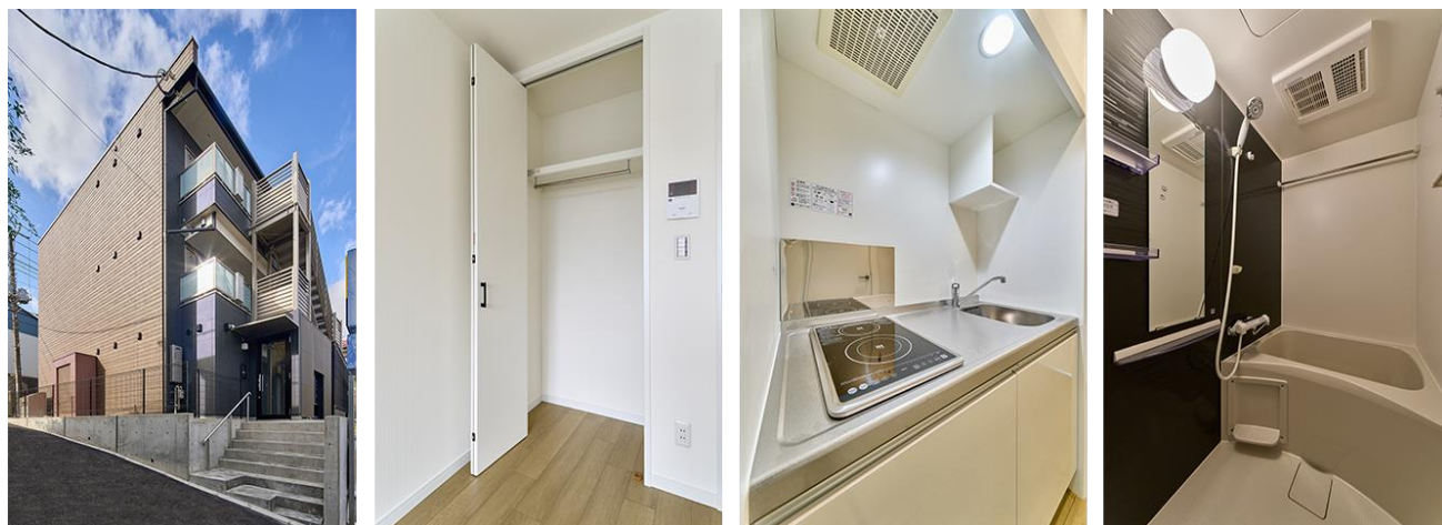
J-ARC 三鷹台 外観および内観写真
